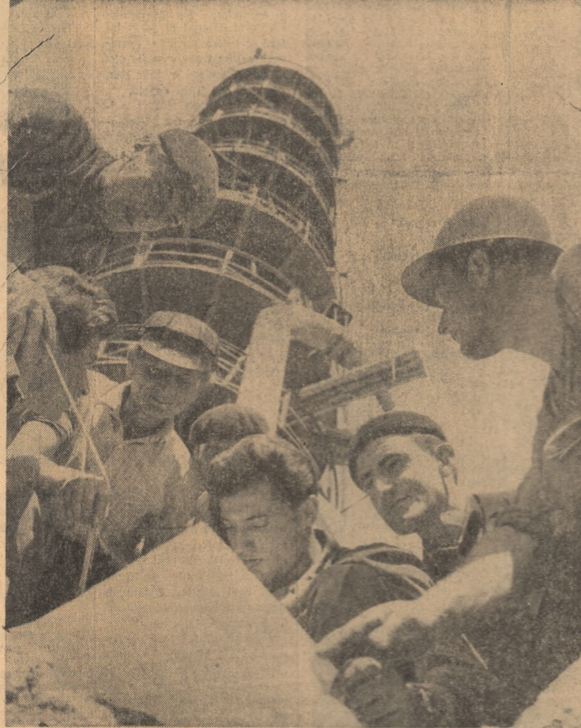
La montarea coloanelor de absorbție pentru acid azotic de la Combinatul de îngrășăminte cu azot — Tg. Mureș, lucrează echipa condusă de Matei Tîlșo, veteran al construcțiilor de acest gen. Fotoreporterul nostru, O. Plecan, l-a surprins pe Tîlșo și pe tovarășii săi concentrînd planul de lucru cu realizările obținute
