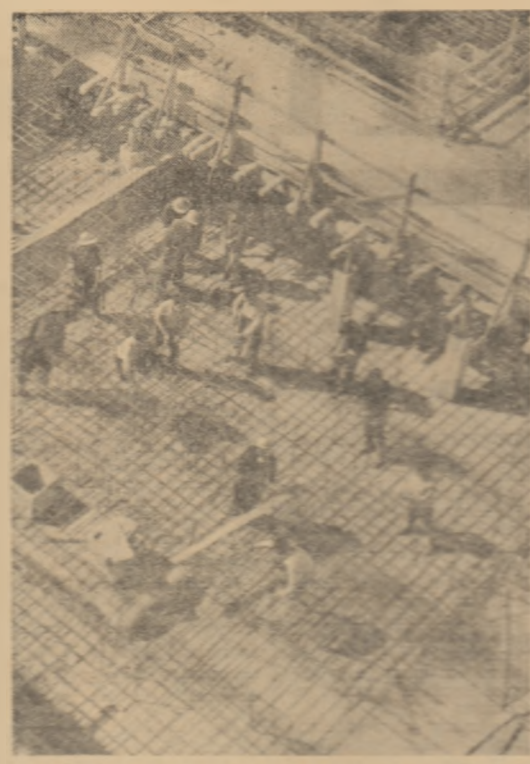
Pe Stadionul Combinatului siderurgic Gheorghiu-Deb, construcția se desfășoară în toamnă. Lucrările de temelire sînt finalizate. Betonajul din echipa condusă de Ion Gheorghiu — echipă formată în întregime din tineri — este în curs de finalizare.
