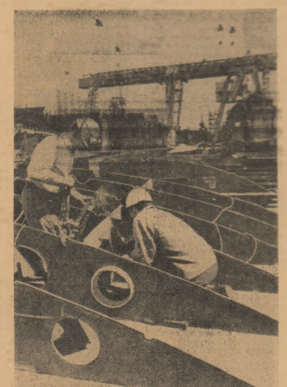
R. D. Germană. Imagine de la montarea vaselor de pescuit la șantierul naval din Wismar. Foto: A.D.N.
