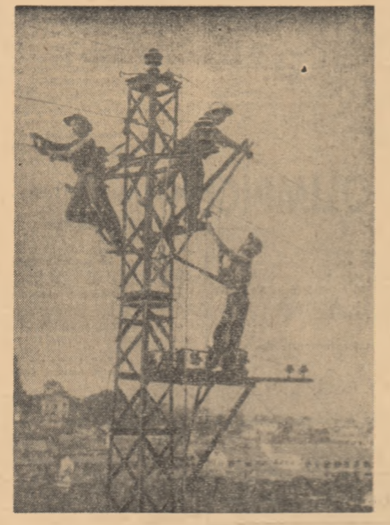
Aspect din timpul verificării liniilor de înaltă tensiune din regiunea minieră Uong Bi (R. D. Vietnam).
