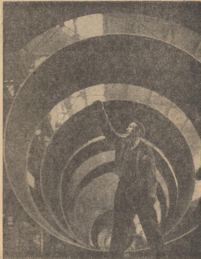
Aspect din secția cazangerie a Uzinelor „Grijița roșie” din Capitală. Foto: ION CUCU
