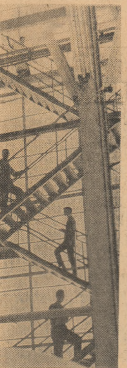
Intr-una din secțiile moderne, nou construite, ale Uzinei de acid sulfuric din Valea Călugărească
