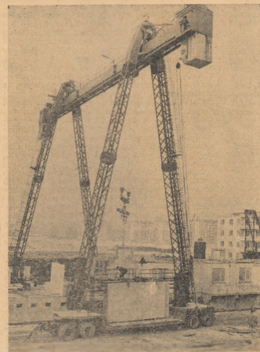
R.D.G. Pe șantierele de construcții din orașul Hoyer Swerda Foto: ZENTRALBILD
