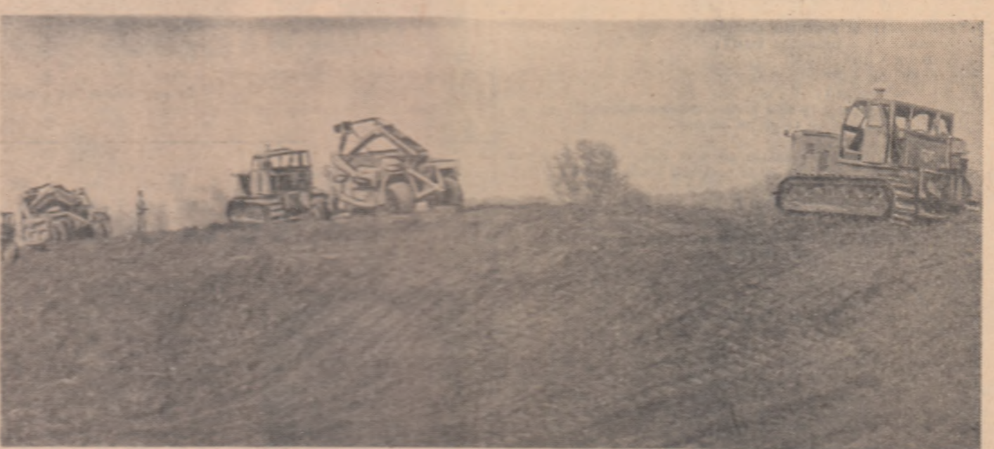
Cupă după cupă, screeperul încălzit și izdească digul, puternic zădărnici împotriva re-vărsării apelor
