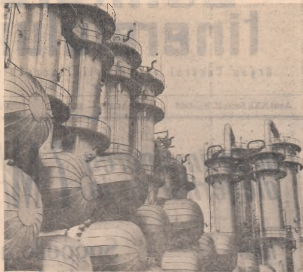
Instalația de regenerare cu acetoneolamină a fabricii de amoniac de la Combinatele chimice Craiova. Foto: O. PLECAN
