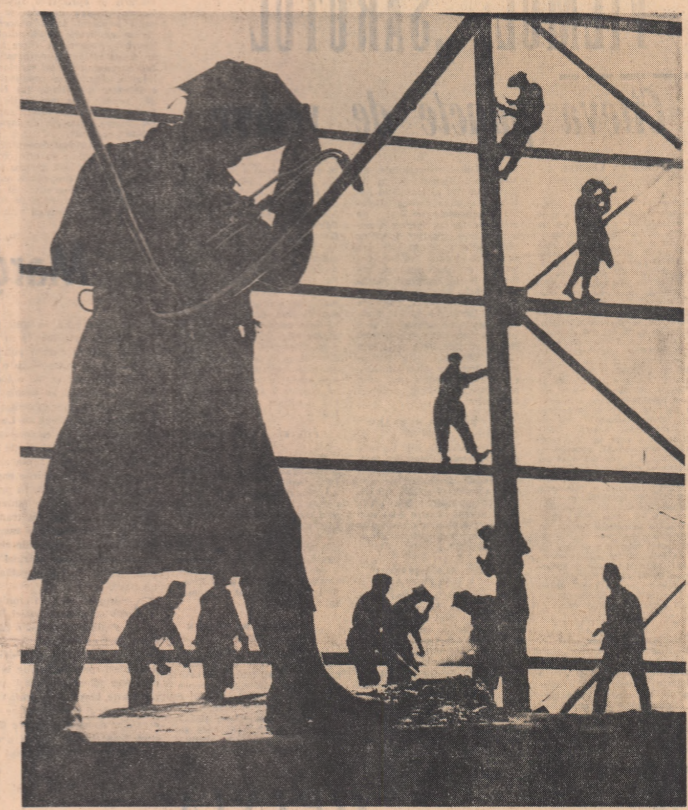
Construcții metalice. (Combinatul chimic de la Baia Mare) Foto: ION CUCU
