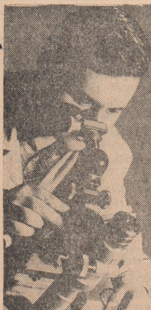
În secția de încercări tehnologice a laboratorului central de la Uzinele „23 August” București, tînărul laborant Alexandru Răduț, determină cu ajutorul microscopului rezistența superficială a constituenților unor aliaje teroase și neferoase
