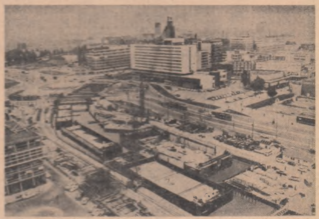
OLANDA: Vedere din centrul orașului Rotterdam, unde se desfășoară lucrările de construire a metroului
