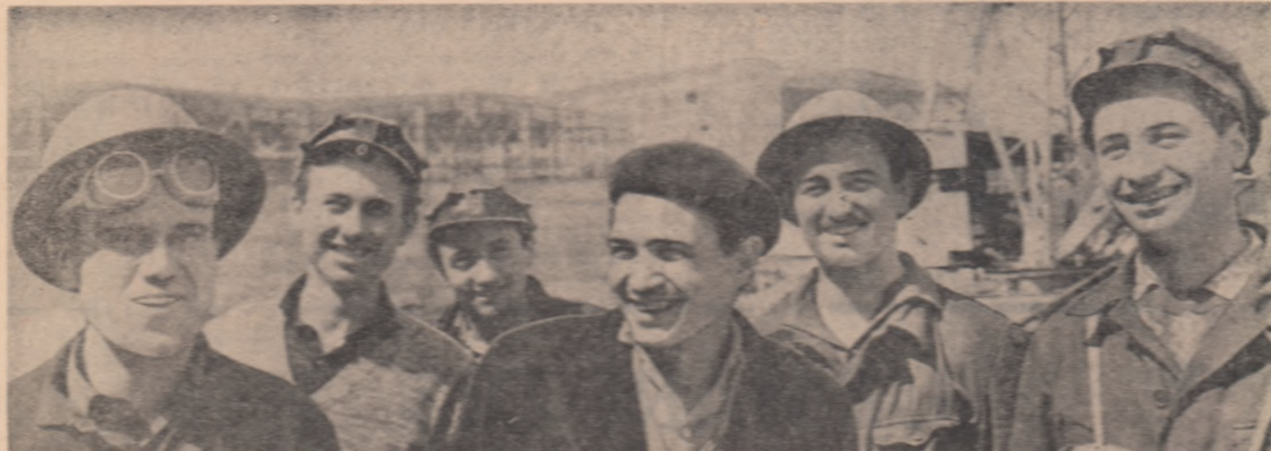
Santierul Uzinei de aluminiu de la Slatina. Printre echipele evidențiate în executarea lucrărilor de montaj se numără și cea condusă de Dumitru Gădăneru (în mijloc). Ea lucră în prezent la aluzarea de aluminiu de 4000 de tone și s-a angajat să termine lucrările, cu 10 zile înainte de termen.
