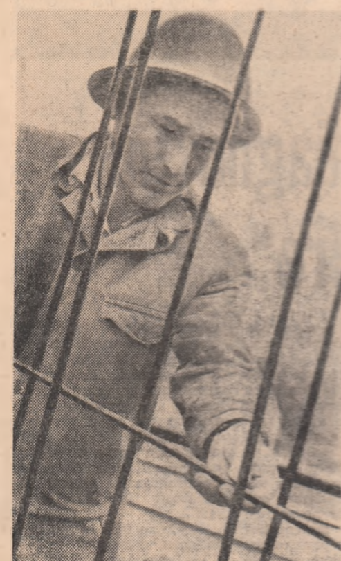
George Tudora, șeful unei echipe de fierari betonisti: „Toate lucrările care mi-au fost repartizate le-am predat cu 10-15 zile mai devreme. Cu această hotărîre mă îndrept și către turbina nr. 2 a centralei electrice”
