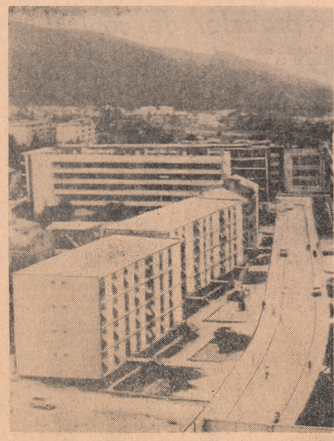
R. S. F. IUGOSLAVIA. — Noi blocuri de locuințe în orașul Split.
