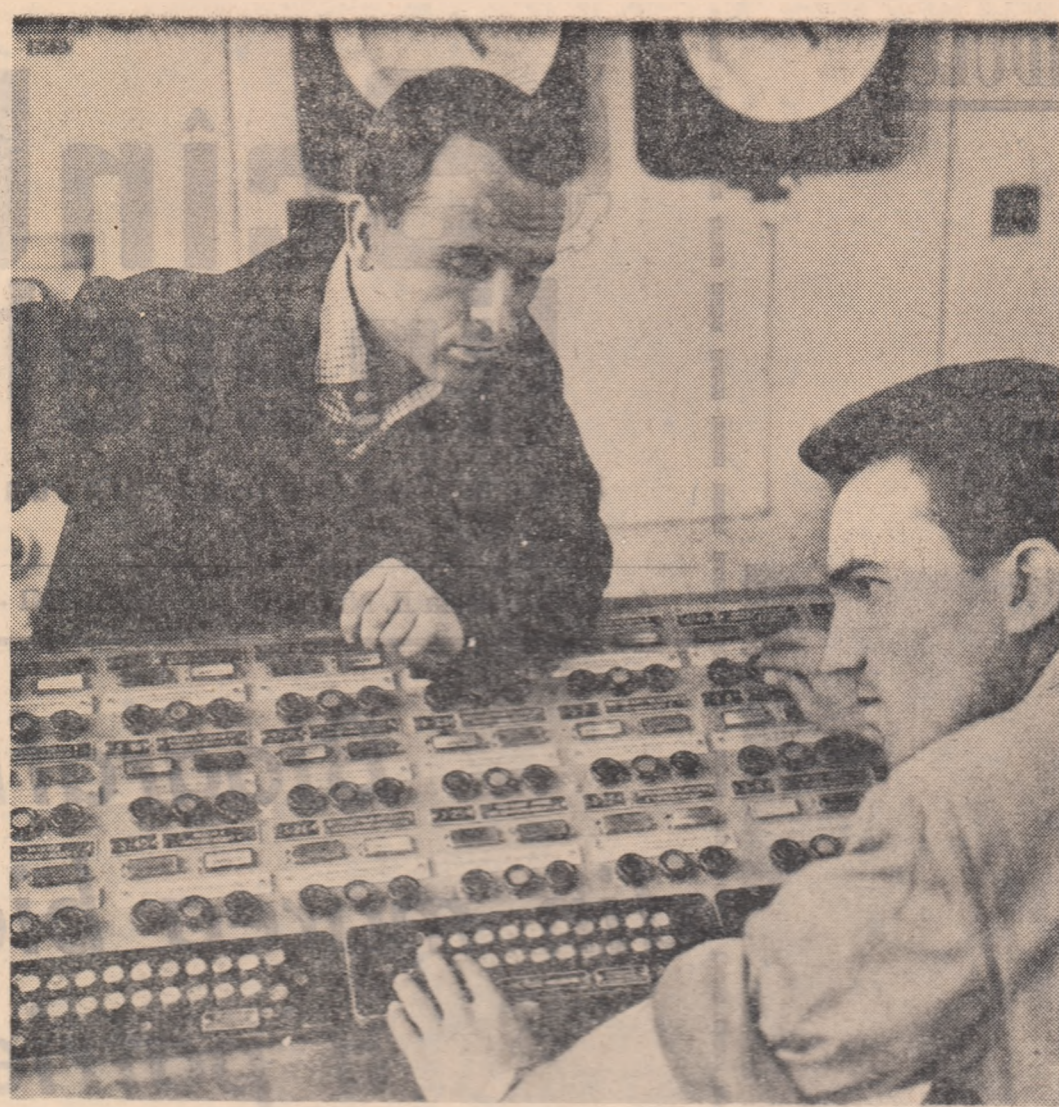
Gratul de automatizare și proceselor tehnologice de la Combinatul de Îngrașăminte cu azot din Pietra Neamț, este sugerat și de acest pasau de comandă de la Fabrica de amoniac
