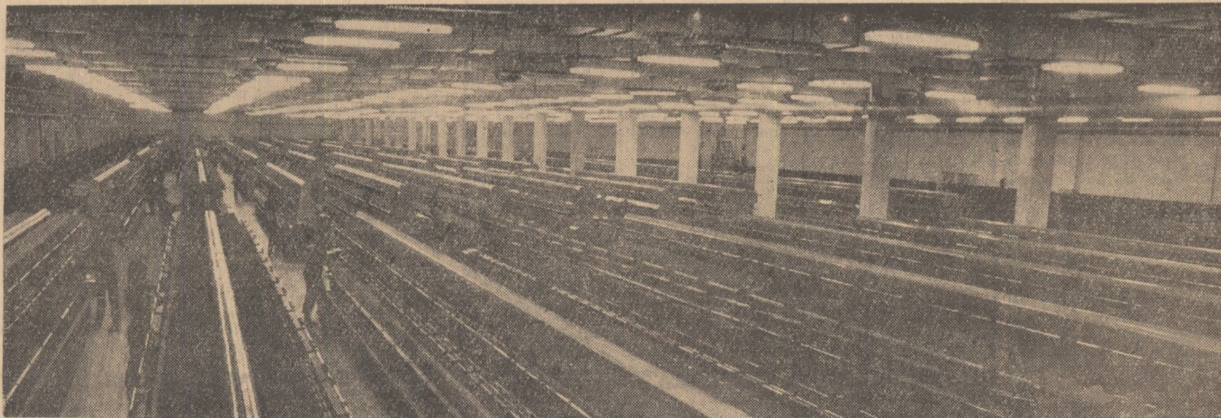
Aspect parțial din secția textilă — atelierul de cablare — a Fabricii de rețea super-supercord din Brăila. Foto: AGERPRES
