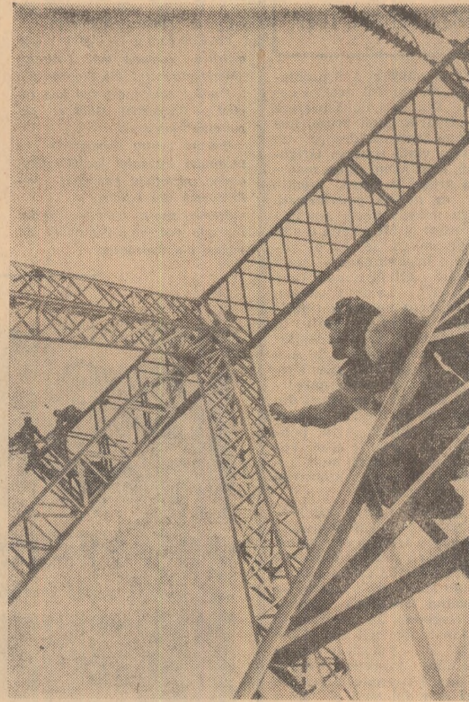
Echipa de montori condusă de Aurel Petru, de pe șantierul liniei electrice de înaltă tensiune Luduș-Slatina, lucrînd la fixarea izolatoarelor
