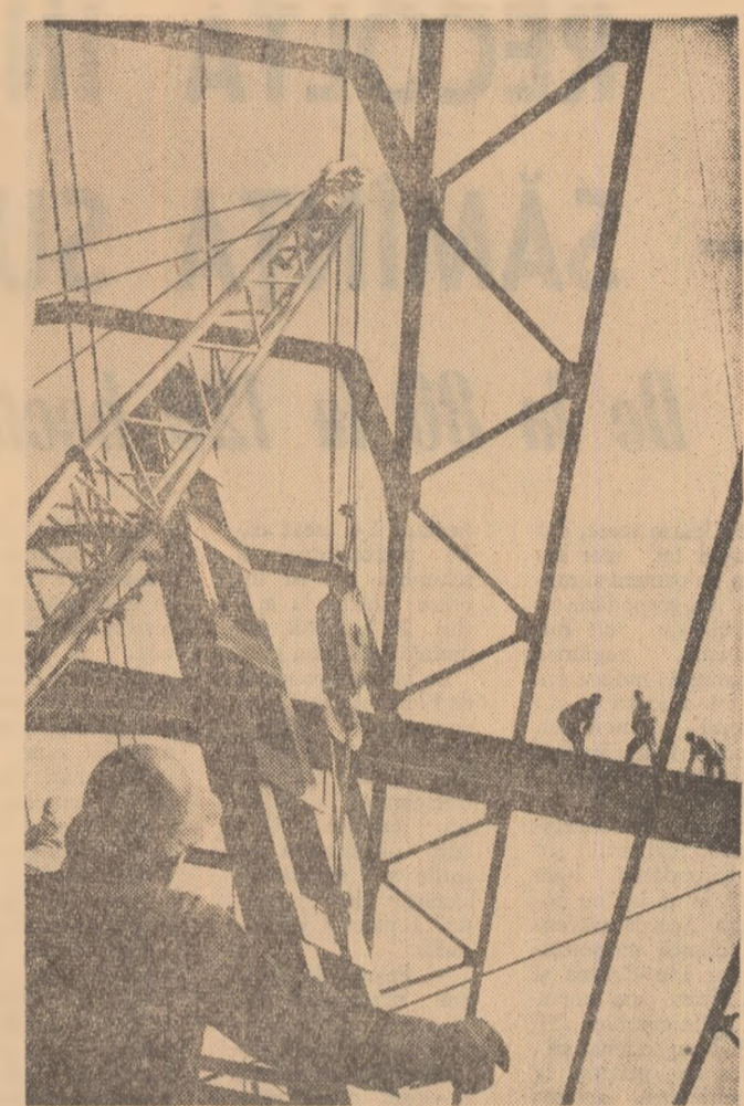
Uzinele „Grivița Roșie” din Capitală. Se lucrează la montarea panourilor metalice și a cadrului luminator de la noua hală. Foto: AGERPRES
