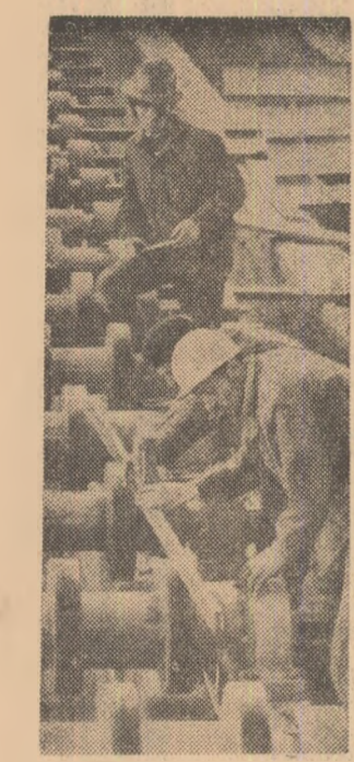
Laminorul de tablă grosă de la Combinatul siderurgic Gheorghe Gheorghiu-Dej Galați. Se lucrează la căile de role, pe unde va fi transportată automat în laminoare tablă.
