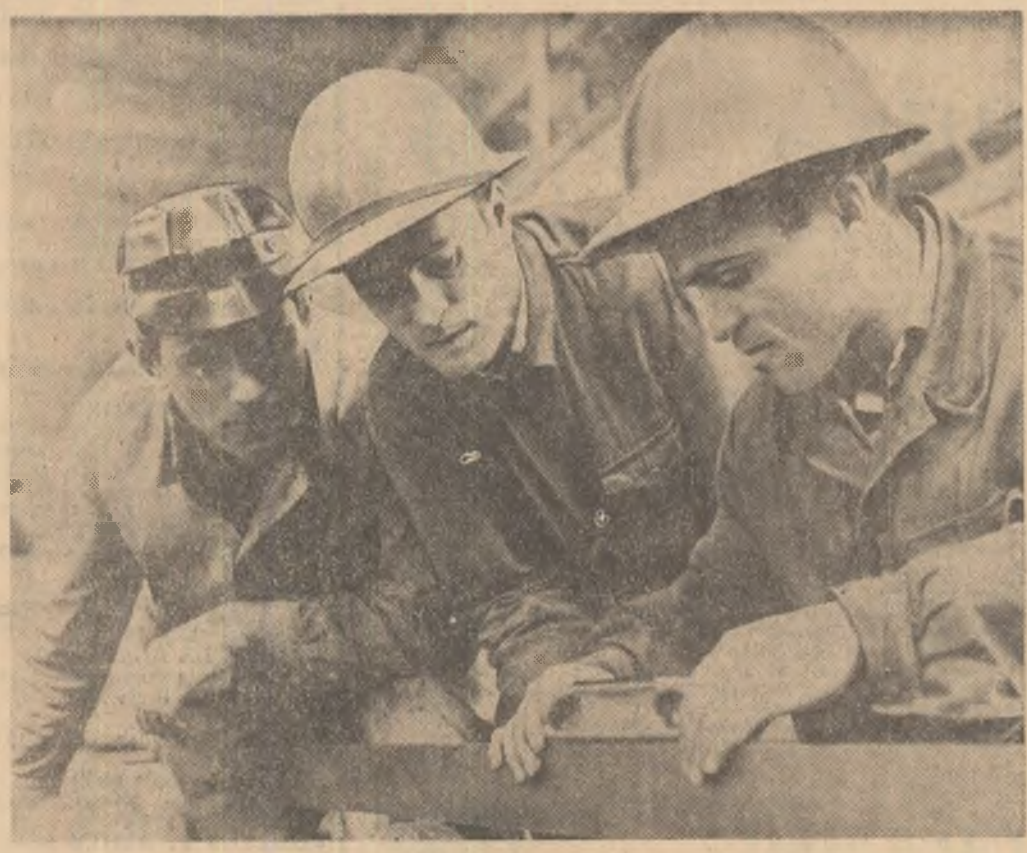
Marin Andrei, Toma Minzala și Petre Nedelcu execută cu grijă lucrări de montaj la laminorul de tablă grosă al Combinatului siderurgic „Georgehe Gheorghiu-Dej” de la Galați
