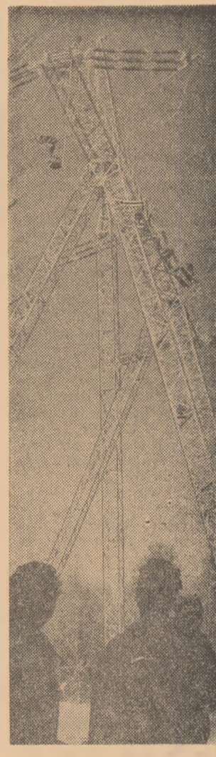
Pe șantierul uneia dintre cele mai importante atiere ale sistemului electro-energetic național — linia de 400 kV Luduș — Slatina — București Foto: AGERPRES
