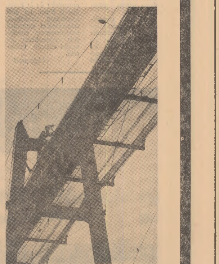
Această dantelărie de fier suspendată la acești de metri înălțime asigură transportul calculului de la cariera Romană Combinatului siderurgic Dej Foto: AGERPRES
