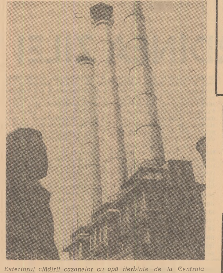
Exteriorul clădirii cazanelor cu apă fierbinte de la Centrala electrică de termoficare-Grozăvești Foto: AGERPRES
