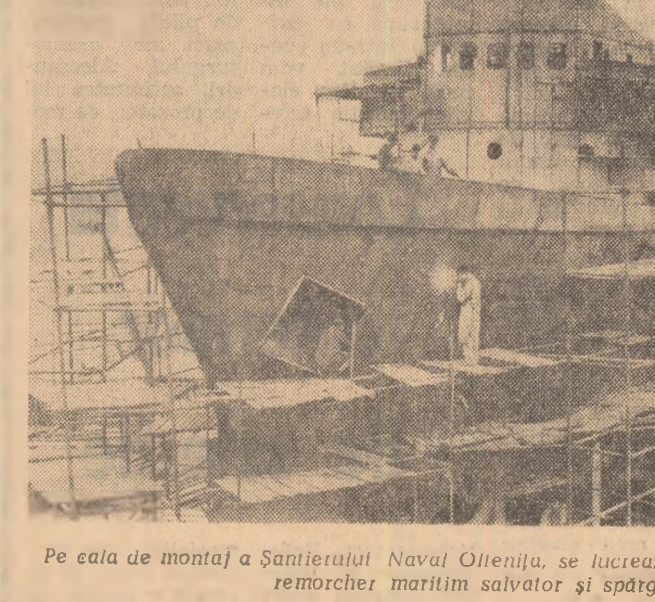
Pe calea de montaj a Șantierei Navale Oltenița, se lucrează la înălțarea corpului primului remorcher maritim salvator și spîrgător de gheață
