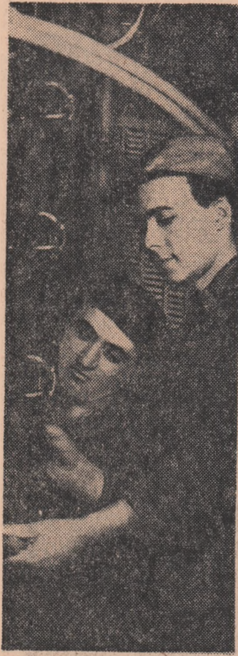
Montorii Dumitru Călinescu și Virgil Poljiță de la Fabrica de transformatoare a Uzinei „Electroputere” Craiova lucrând la conexiunile unui transformator 20 MVA
