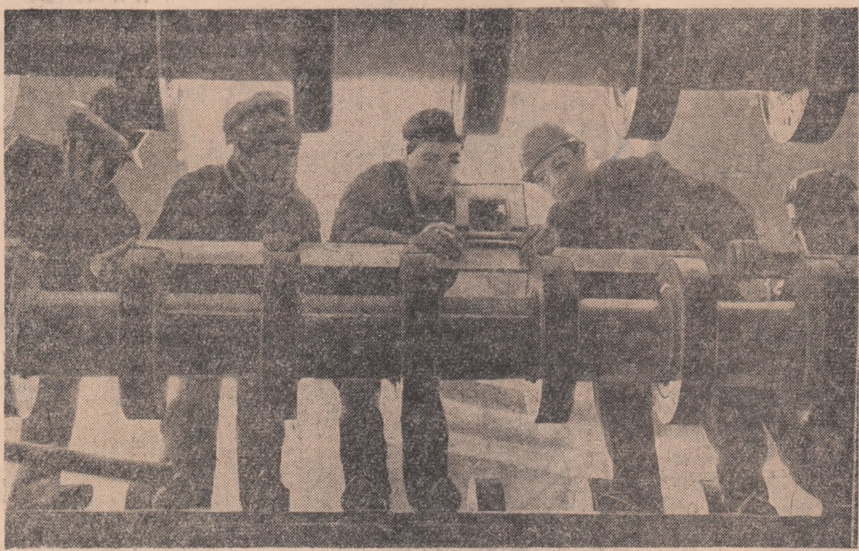
În sala laminorului de tablă groasă de la Combinatul siderurgic „Gheorghe Gheorghiu-Dej” din Galați obiectivul aparatului fotografic a surprins una din ultimele jaze ale montajului — centrarea căilor cu roje.
