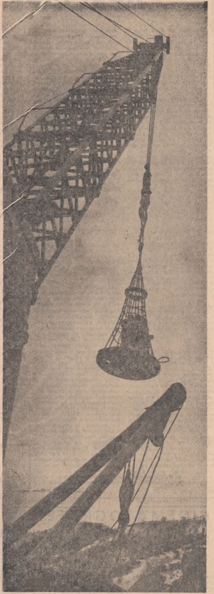
Deasupra cerului, dedesubt apele fluvului. Între ele — un zbor curajos spre marele batardou celular al adpostului cîrma se va construi batajul hidrocentralei
