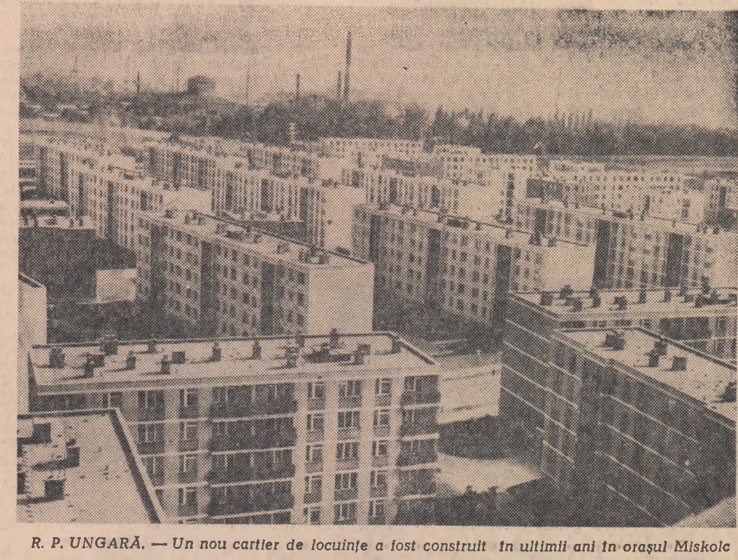
R. P. UNGARĂ. — Un nou cartier de locuințe a fost construit în ultimii ani în orașul Miskolc
