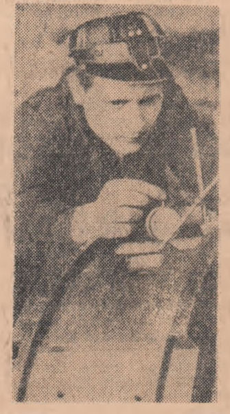
Centrala termoelectrică Luduș-Ierul. Tînarul Azariței Constantin , împreună cu echipa pe care o conduce, s-a angajat să termine lucrările de montaj la turbina a V-a de 200 MW cu 30 de zile înainte de termen. Foto: O. PLECAN
