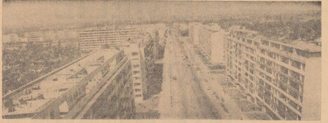
Construcții noi în cartierul Giulești
