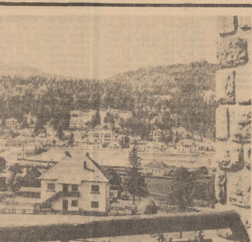
Imagine des întîlnită pe vederile trimise din concediu. Această localitate se află la cea mai mare altitudine pe linia electrică de cale ferată recent dată în funcțiune
