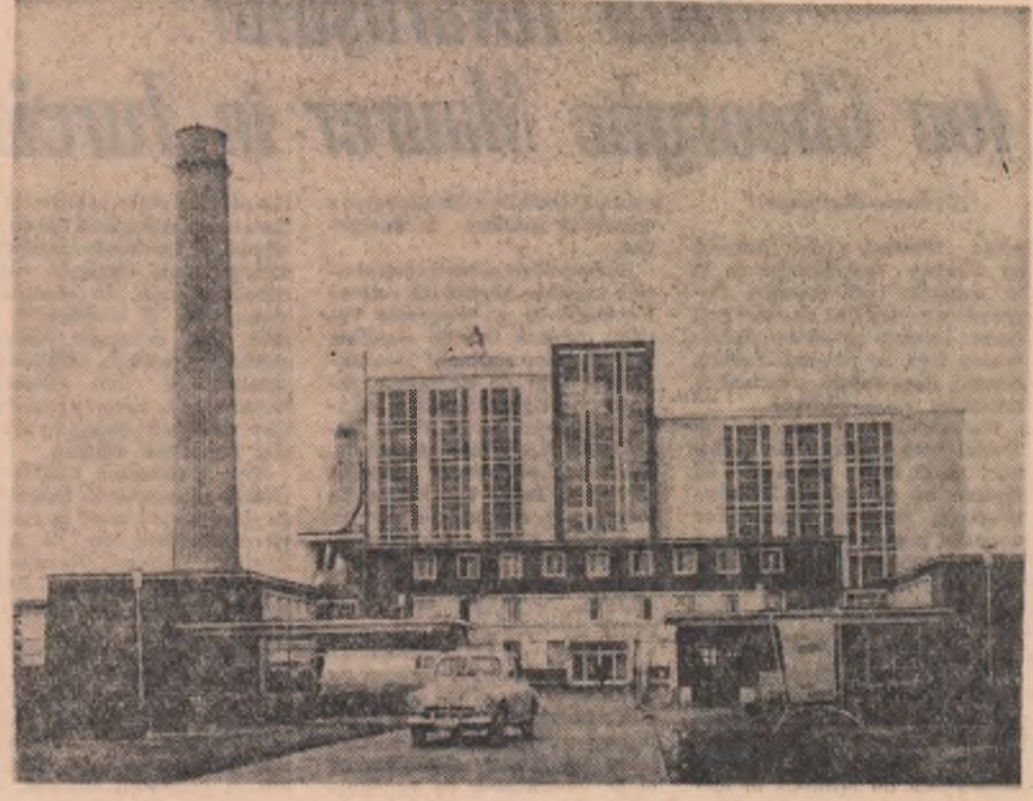
Centrala electrică de termoficare Brazi
