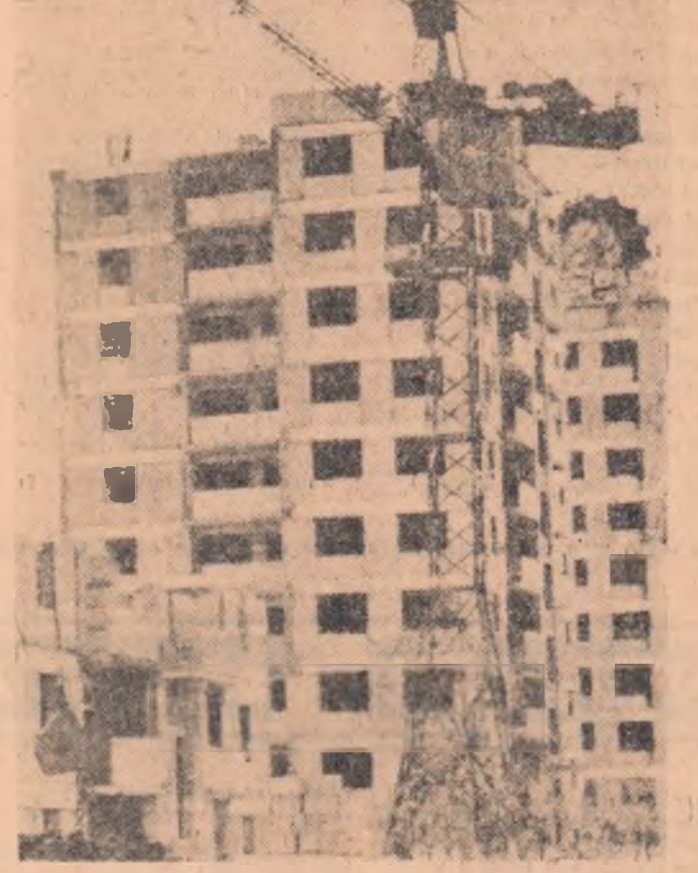
R. P. D. COREEANĂ. — Pentru înălțarea noilor blocuri de locuințe din Phenian, constructorii folosesc pe scară tot mai largă prefabricatele
