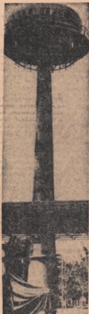
R.S. CEHOSLOVACĂ. Turn de apă înalt de 33 m, cu o capacitate de 152 mc. realizat de întreprinderea Kralovopolski
