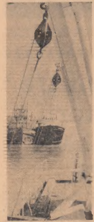
Vedere de pe Șantierul naval Olenița. În planul doi draga de 400 m c și primul spargător de gheață care se pregătesc pentru a pleca în primul lor drum
