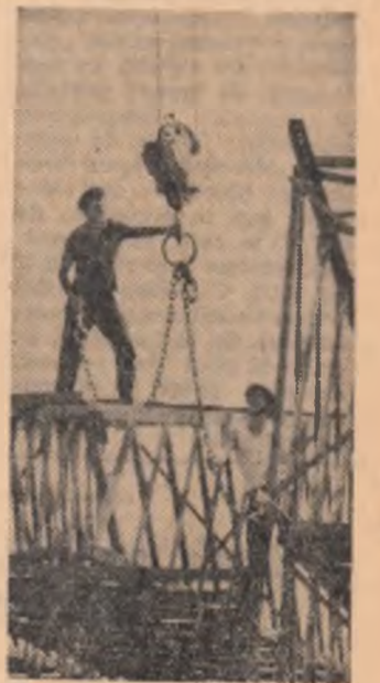
Tronsoanele argintii ale liniilor de înaltă tensiune capătă mai înții contur aici, la secția Oltepeni a întreprinderii de construcții metalice și prelabicative — București
