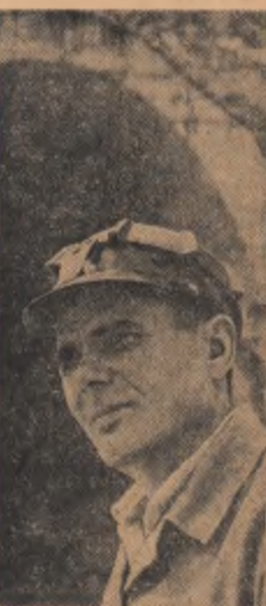
Constantin Sirghie, șef de brigadă mineri betonisti lucrează la tunel-ieghe Tulari, de lângă Orșova, la vîltoarea cale ferată de la Porțile de Fier
