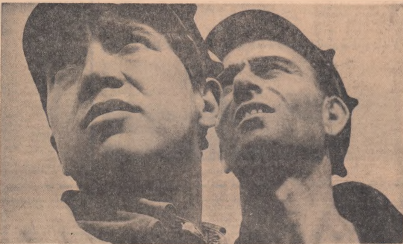
Veohi șantierist, șeful de echipă Ion Uhaș 11 calificat la locul de muncă în meseria de betonist pe tîndrul Constantin Mihăilă Foto: I. CUCU
