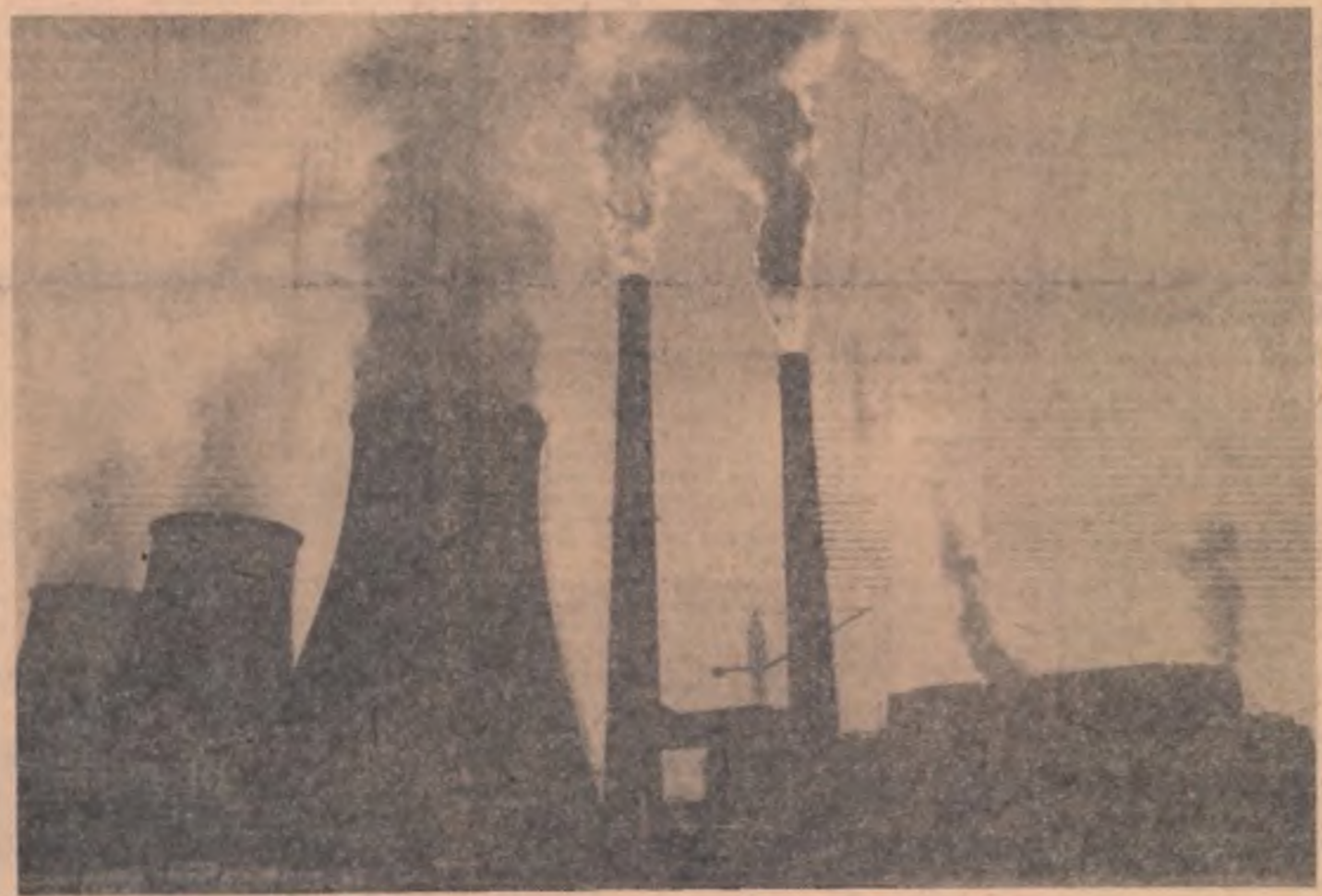
Termocentrala București-Sud Foto: ION CUCU
