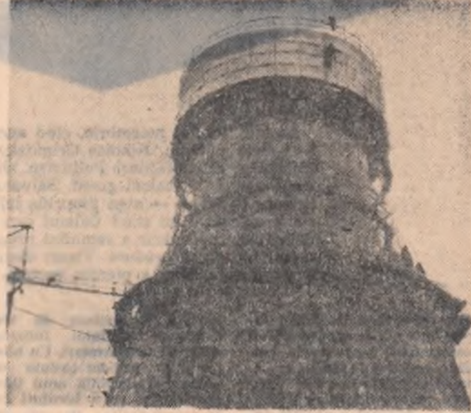
Cosul de fum. În curs de construcție, de la centrala electrică de termoficare Craiova, care va fi una dintre cele mai înalte construcții din țară.
