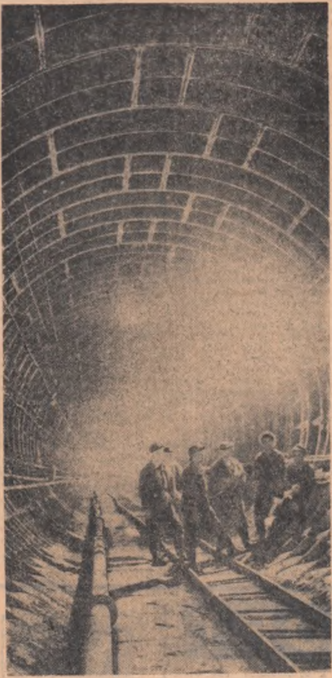
U.R.S.S. La Baku, lucrările pe șantierul metroului sînt foarte avansate
