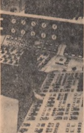
Interior de la Centrala electrică de termoficare Brazil
