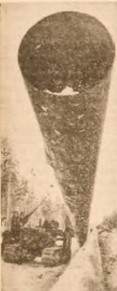
U.R.S.S. — Regiunea Tiumen. Construcția conductei petrolifere Ust-Balik-Omsk
