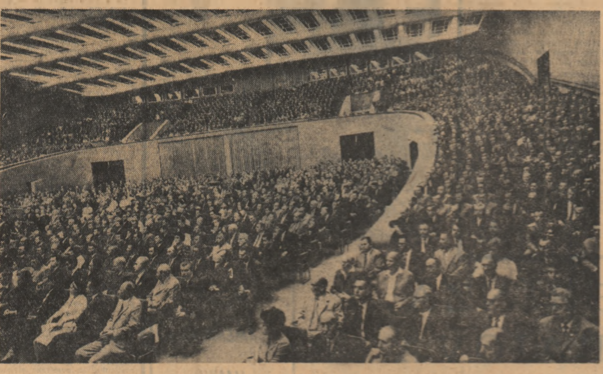
În timpul lucrărilor
