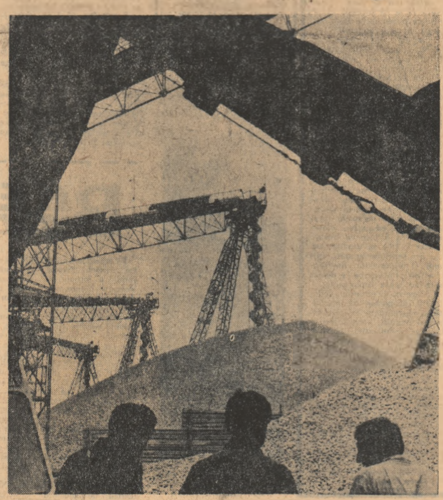
Porțile de fier. Benzile poartă fără întrerupere materialele de la stația de sortare la depozitele de agregate.
