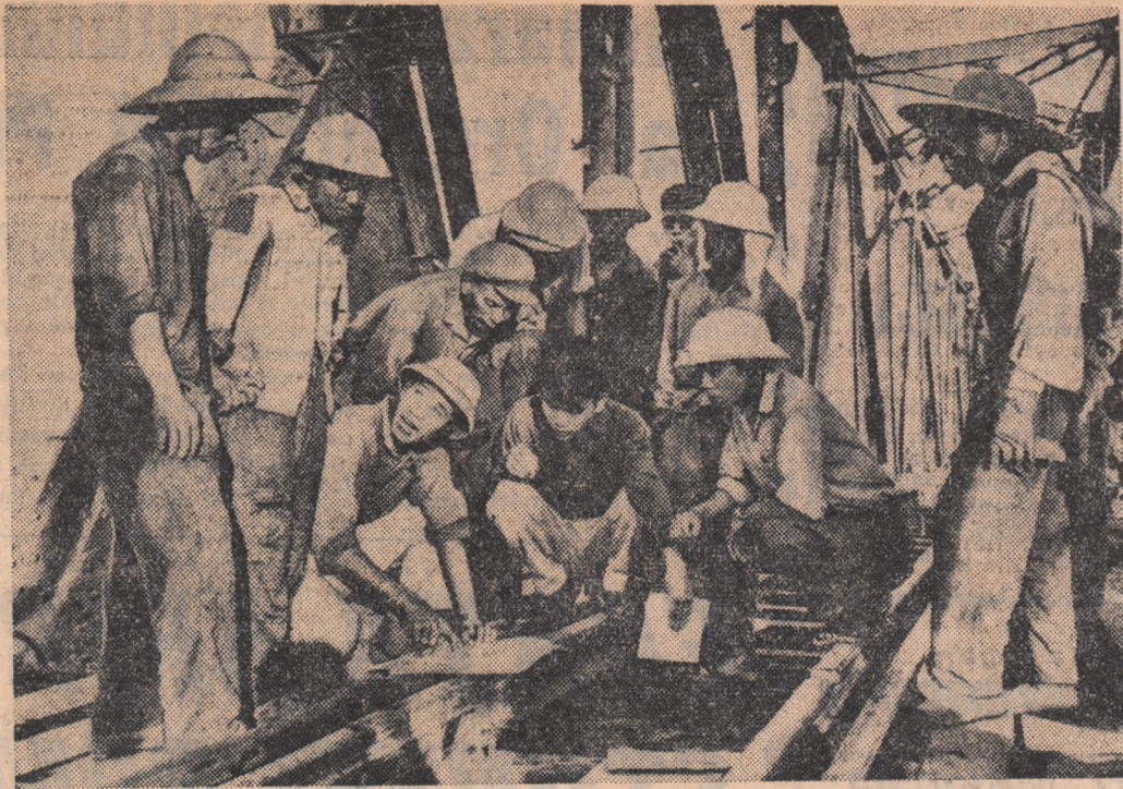
R. D. VIETNAM. — O echipă de intervenție lucind la repararea unui pod bombardat de aviația americană
