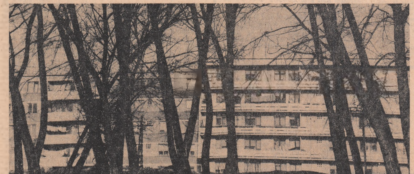
Municipiul Căldărași: Blocuri noi pe cheul Borcet Foto: ION CUCU
