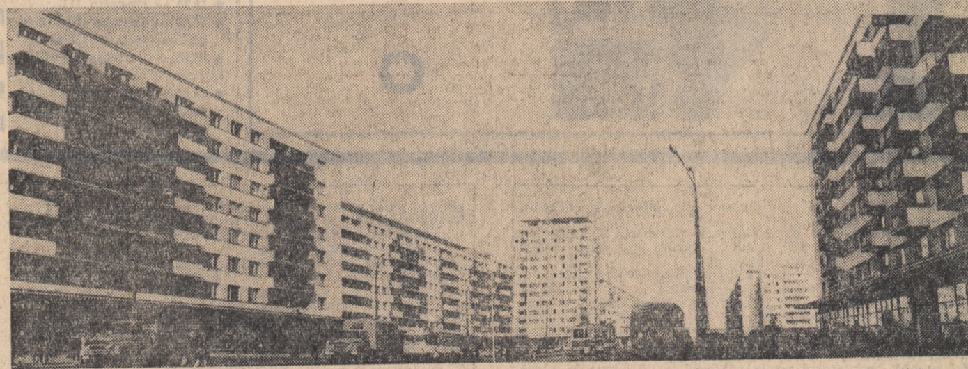
Linii de fugă în Piața Chibrit din Capitală
