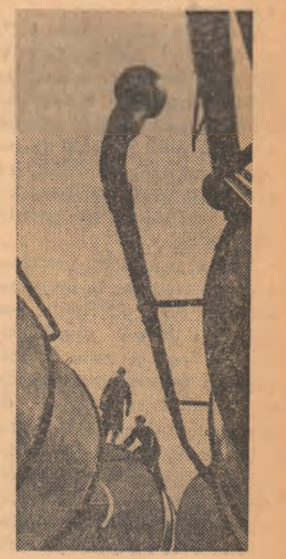
Uzina mecanică Buzău. Se execută lucrări de montaj și finisaj a silozurilor pentru ciment
