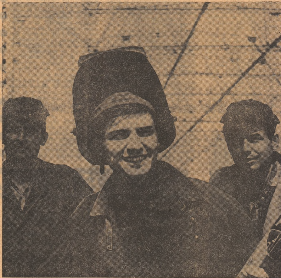
Cornel Stelian (în prim plan), lăcătuș montator la I.S.C.M. Slatina are de ce să zîmbească obiectivului: 1) Lucrează pe șantierul uzinei de aluminiu încă de la prima cărămîdă; 2) e în clasa XI la liceul seral; 3) un ghîd serios pentru viitor — examen de admitere la Facultatea de construcții
